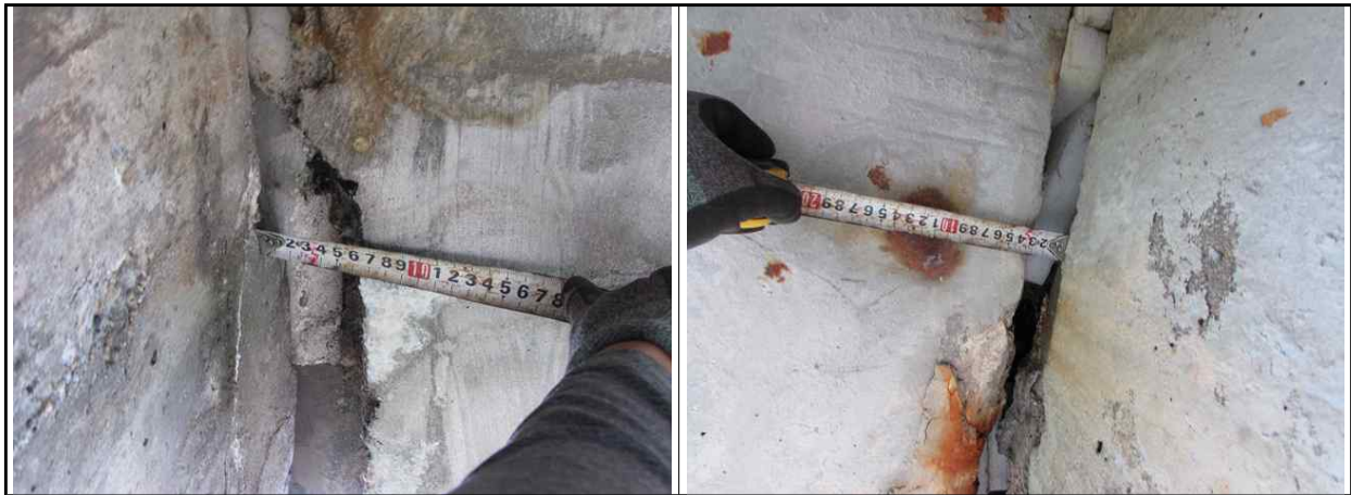
바닥판 유간 측정
